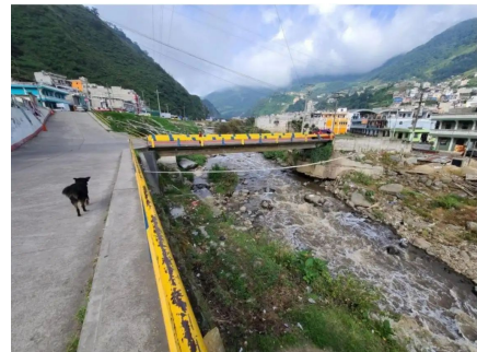
Figura 108: Puente sobre río Salamá Fuente: Prensa Libre - CUNOC- USAC
