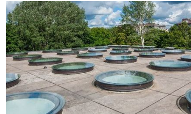
Figura 14 - Cubierta Biblioteca de Viipuri, Fuente: Circarq
