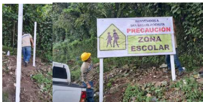
Imagen 19: Colocación de señalización “ZONA ESCOLAR” frente a escuela San Rafael, San Miguel Pochuta, Chimaltenango.
