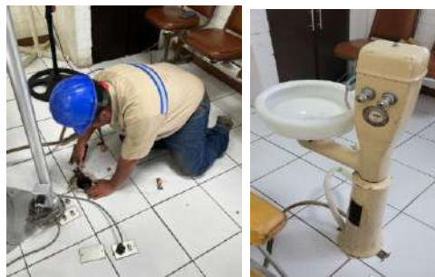
Imagen 8: Mejoramiento del anclaje de la escupidera dental en clínica dental SICASA, San Miguel Pochuta, Chimaltenango.
