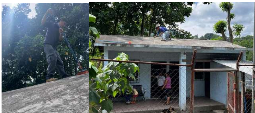
Imagen 15: Limpieza y preparación del techo del centro comunitario, San Miguel Pochuta, Chimaltenango.
