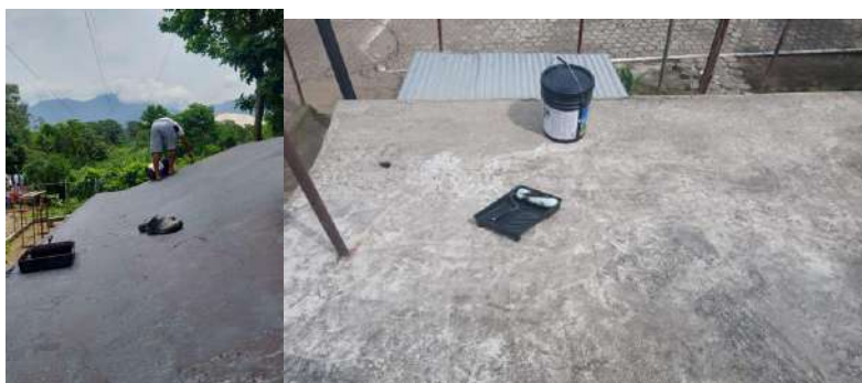
Imagen 16: Aplicación de impermeabilizante en techo del centro comunitario, San Miguel Pochuta, Chimaltenango.
