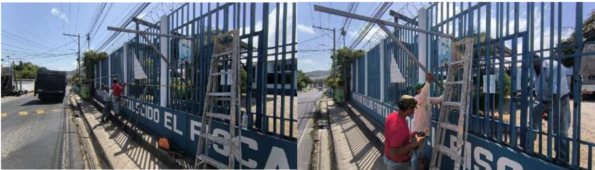
Figuras 8 y 9: Medición y colocación inicial de estructura de soporte del proyecto comunitario.
