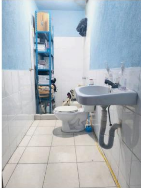
Fotografía No 16. Resultado final del estado de la infraestructura del sanitario
