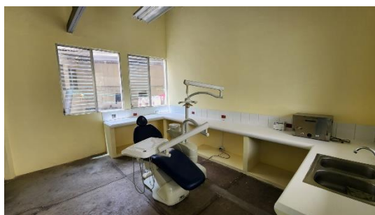
Fotografía 11. Instalación finalizada de la unidad dental
