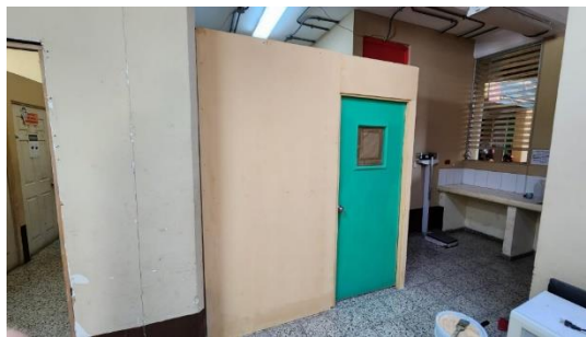
Fotografía 3. Instalación de la tabla yeso y pintura
