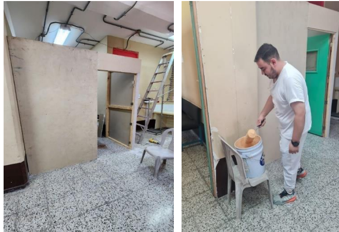
Fotografía 3. Instalación de la tabla yeso y pintura
