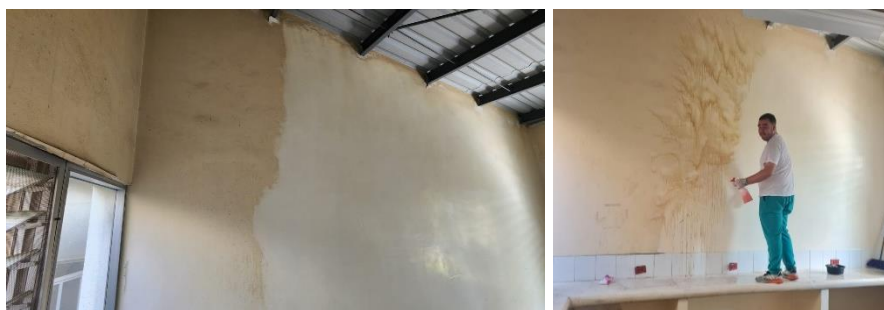
Fotografía 6. Limpieza y evaluación del estado de las paredes
