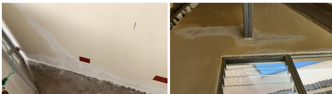
Fotografía 7. Reparación de las paredes
