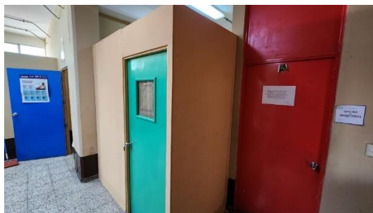
Fotografía 4. Cuarto para personal de ambulancia finalizado, frente al cuarto de descanso del personal médico del centro de salud
