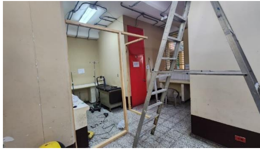
Fotografía 2. Colocación de parales de madera para estructura de la tabla yeso
