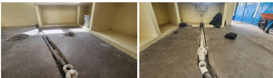
Fotografía 10. Instalación subterránea de tubería de agua, aire y drenaje para la unidad dental.
