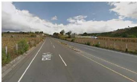
Vista 5 Ingreso por carrtera hacia guatemala
