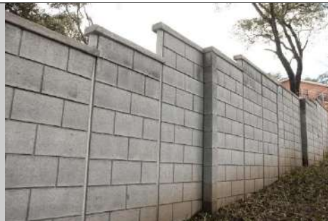
Ilustración 94 Muro de circulación
