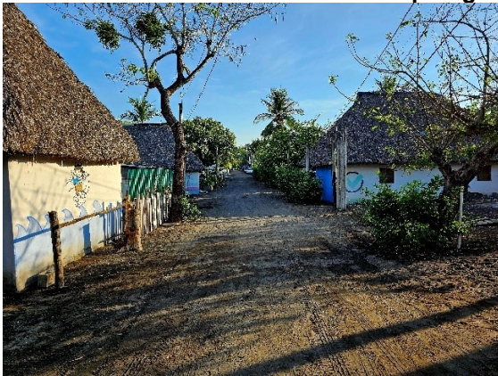
Modelo de viviendas típicas del pueblo Cubiertas de palma, muros de block con revestimiento.
