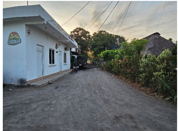
Alteraciones de la vivienda típica, para convertirla en hostel con aire acondicionado. Otras alteraciones se hacen para colocar un local comercial.
