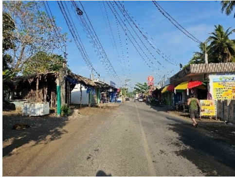
Vista de tramo de este a oeste Obsérvese que no tiene banquetas y los comercios sacan sus ventas en la orilla
