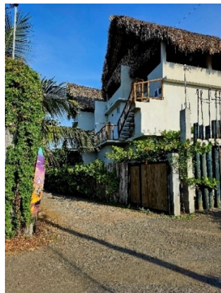
La arquitectura de los nuevos desarrollos de albergues para al turismo suelen ser de varios niveles, con estructura de concreto y block de pómez, recubrimiento blanqueado y con cubierta final de palma.
