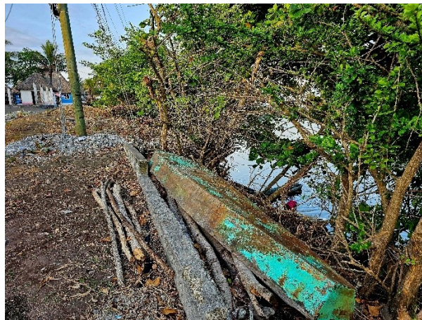
Figura 63. Moderada calidad visual y mediana fragilidad visual del área oeste del borde del estero desde la aldea El Paredón Buena Vista. Deterioro visual y ambiental generado por los pobladores.
