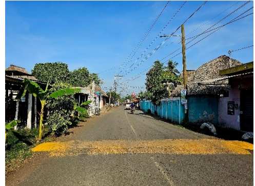
Vista de tramo de este a oeste Nótese que algunas propiedades como la del muro color aqua, tienen construcción al borde del asfalto.
