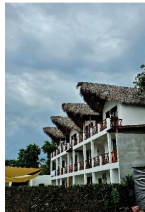
La arquitectura de los nuevos desarrollos de albergues para al turismo suelen ser de varios niveles, con estructura de concreto y block de pómez, recubrimiento blanqueado y con cubierta final de palma.
