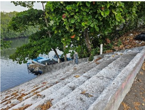
Acercamiento de primer bloque de gradas para embarcadero que descienden al estero.
