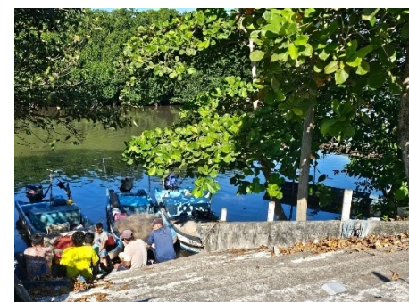
N. Embarcadero con gradas en el lindero oeste del estero.
