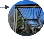
Pérgola metálica +lámina de Aluzinc
