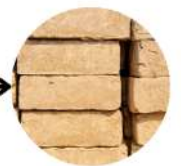
Muros de Adobe
