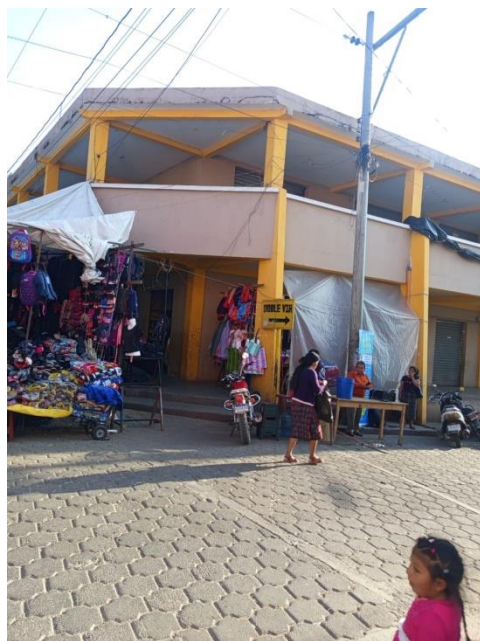
Figura 5. Deterioro del mercado actual, diseñado únicamente para 2 niveles, saturación de ventas o comerciantes a sus alrededores del mercado que no permiten carga y descarga de producto en San Miguel Ixtahuacán.
