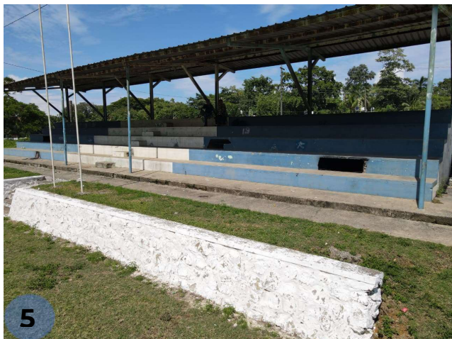
Ilustración 55. Estado actual de graderío Fuete. elaboración propia
