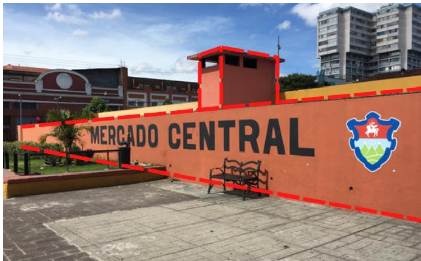
Figura 52. Fachada Principal. Elaboración propia con base en mapas de Google.
