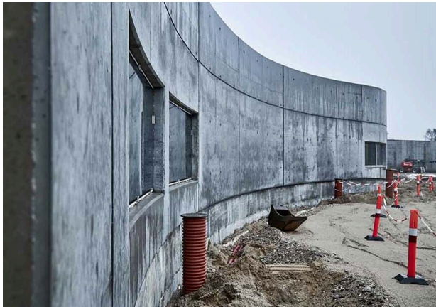
Figura 33. Construcción de paredes del área multifuncional
