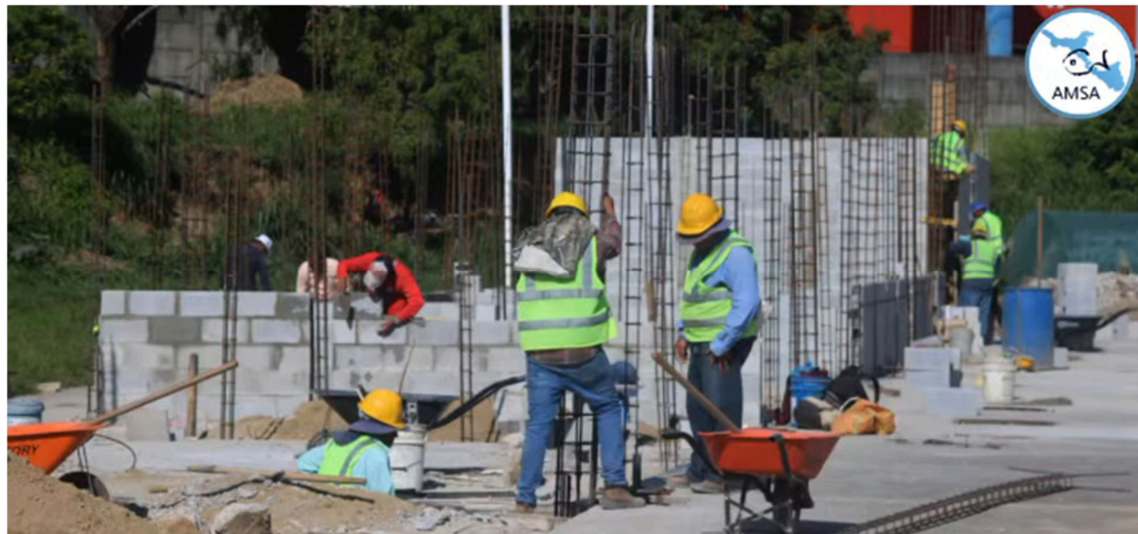
Figura 41. Construcción de la planta de separación de desechos AMSA.
