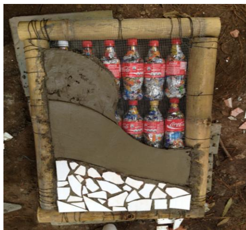
Fotografía 33: Detalle de un muro de bambú con núcleo PET
