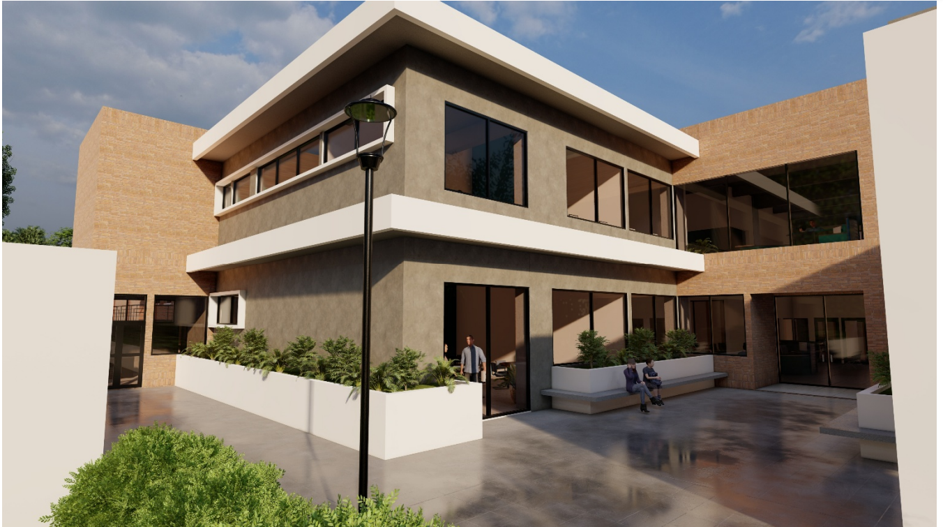
Apunte exterior – Ingreso principal a edificio desde nivel de plaza.
