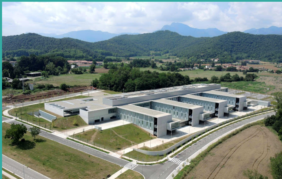
Fachada posterior Hospital D'olot i Comarcal. (Fotografía Salvador Aumatell Cufi).
