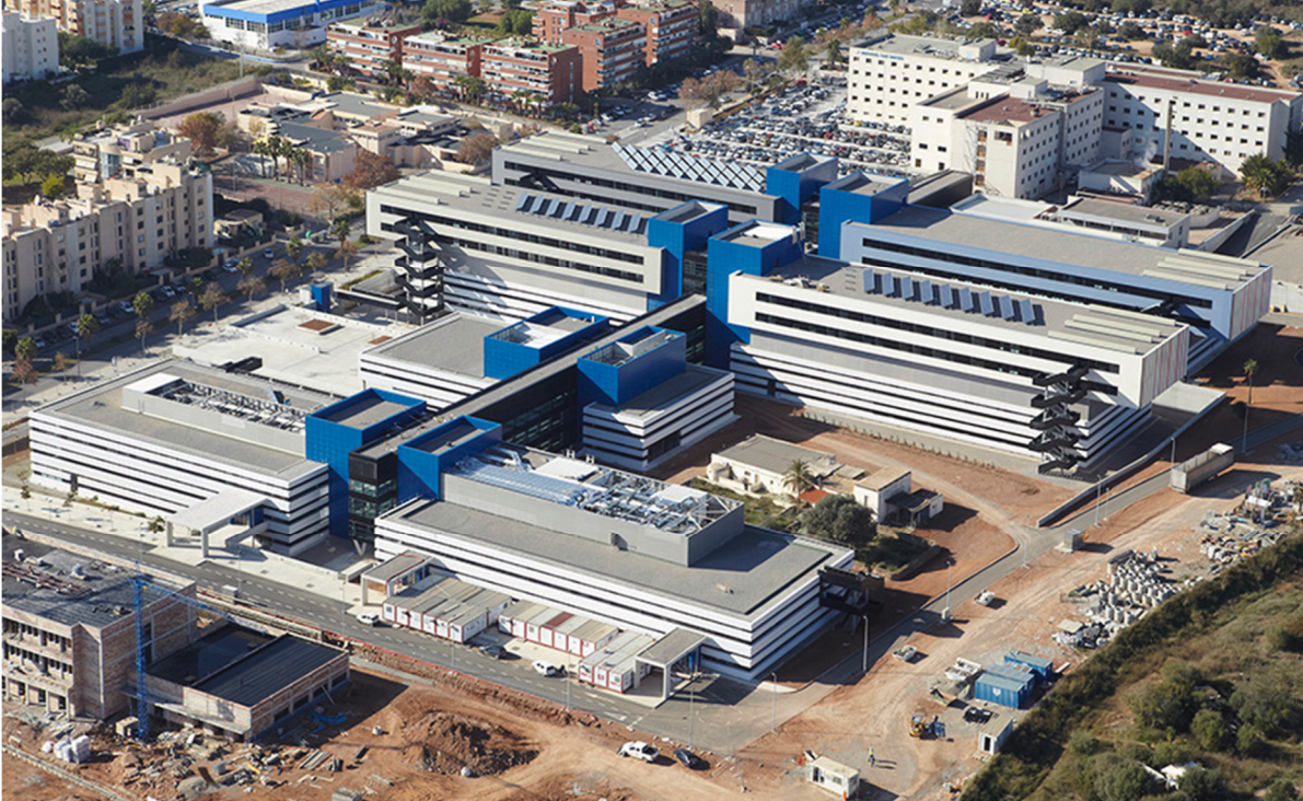
Hospital Can Misses. Fotografía: Xavi Duran.
