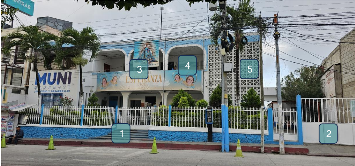
Figura 33. Fachada Edificio Municipal Sanarate. Fuente: elaboración propia
