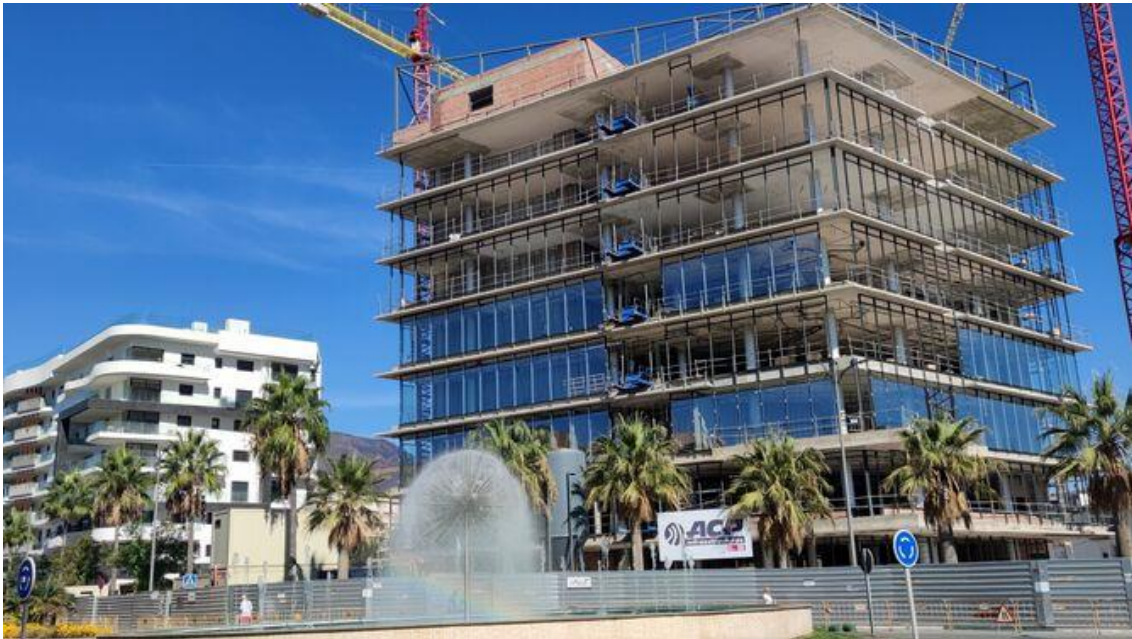
Figura 36. Vista de las obras del nuevo Ayuntamiento de Estepona. Fuente: https://static.grupojoly.com/clip/bcd3dd91-2600-4e4a-8b47-a4e122ae8a98_twitter-aspect-ratio_default_0.jpg
