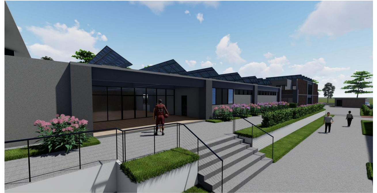
VISTA EXTERIOR EDIFICIO DEPORTIVO
