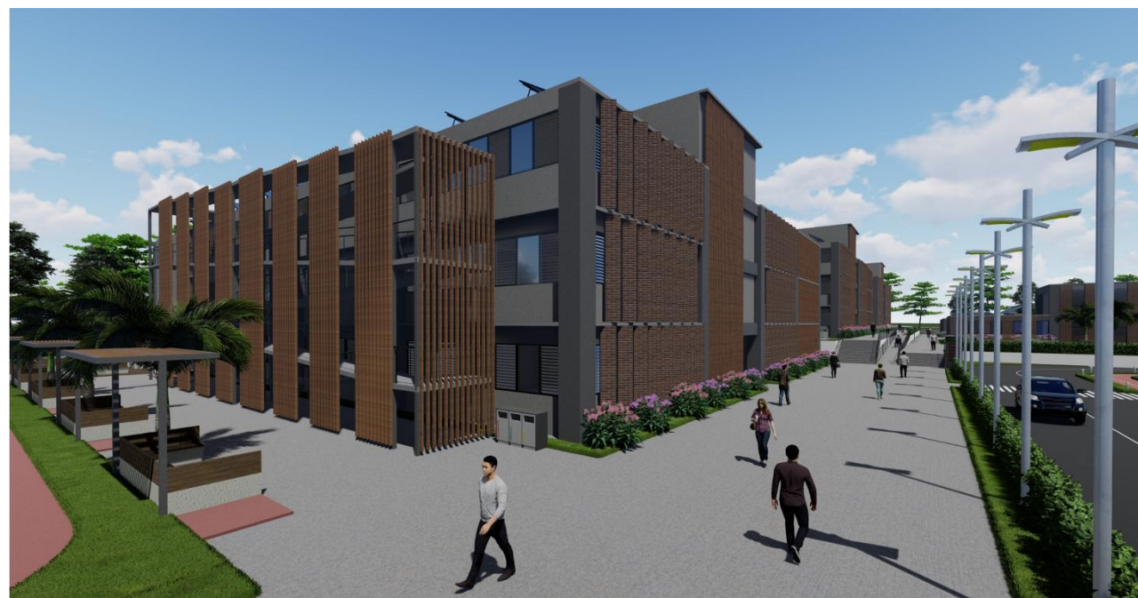
VISTA EXTERIOR EDIFICIO EDUCATIVO
