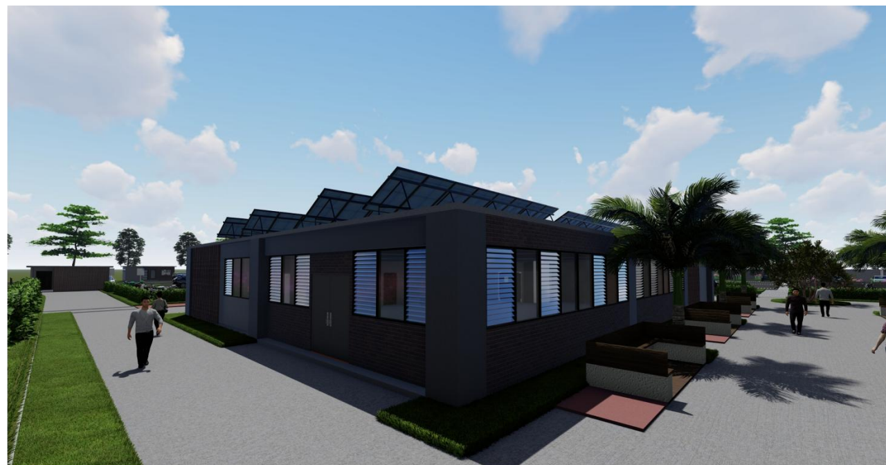
VISTA EXTERIOR CAFETERÍA
