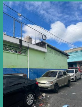
Figura 86. Abastecimiento agua potable del mercado. Fuente: Carlos Aroche
