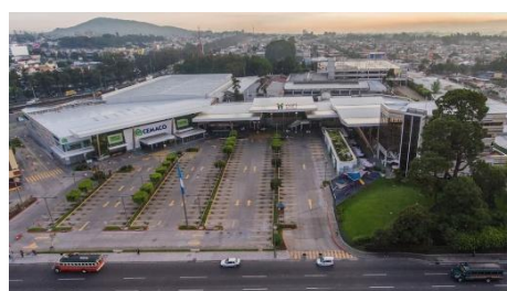
Figura 63. Imagen aérea Centro Comercial Peri-Roosevelt.
