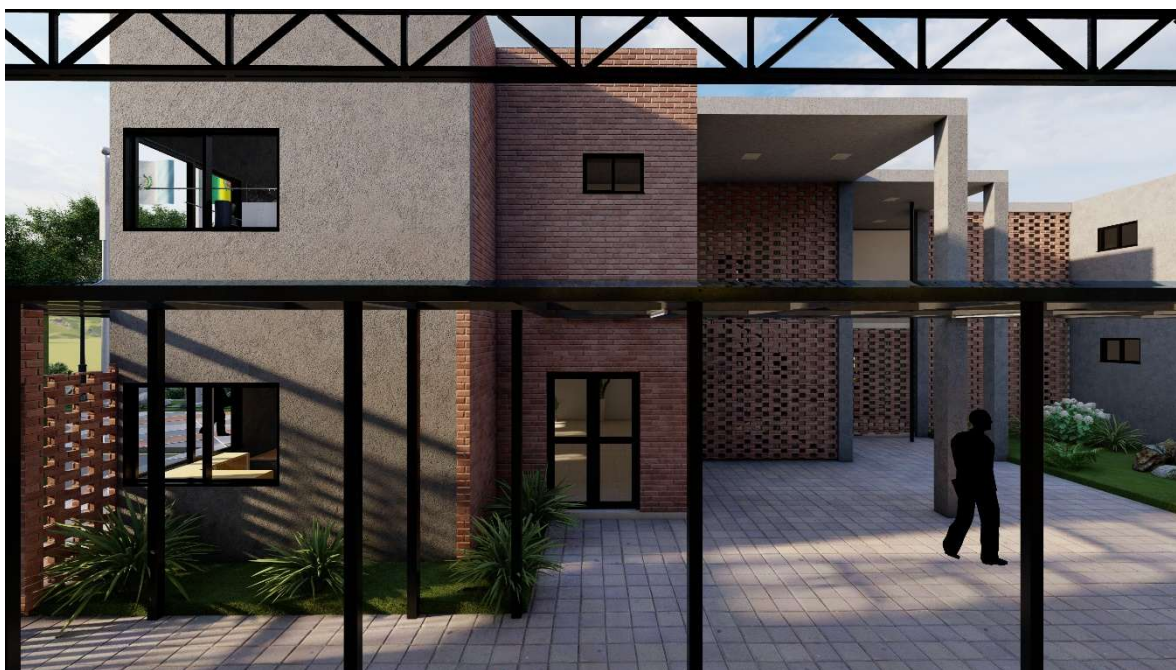
VISTA EXTERIOR FACHADA INTERNA
