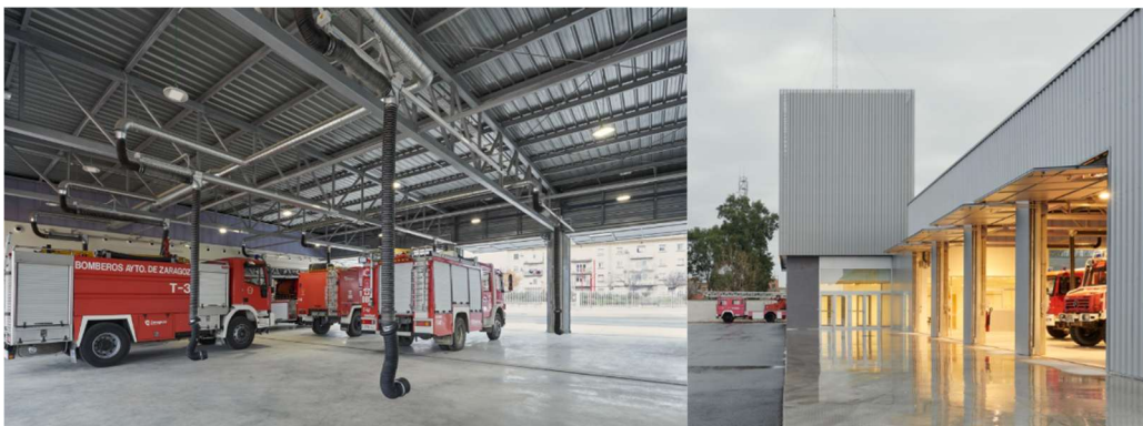
Figura 29 y 30: Vistas exteriores Estación de Bomberos No.4 Zaragoza, España, agosto, 2024. Fuente: ArchDaily.
