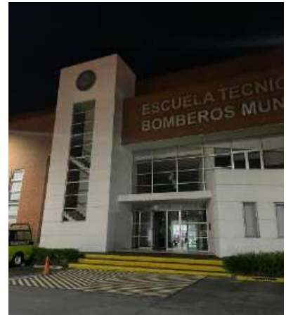
Figura 18: Fotografía exterior Estación de Bomberos Municipales No.2, agosto, 2024. Fuente: Elaboración propia.
