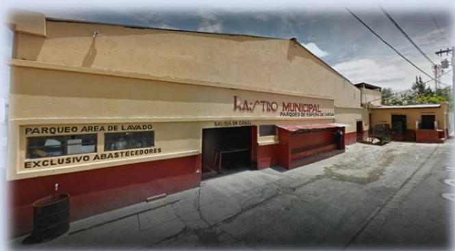
Fotografía No.18 Rastro Municipal de Santa Catarina
