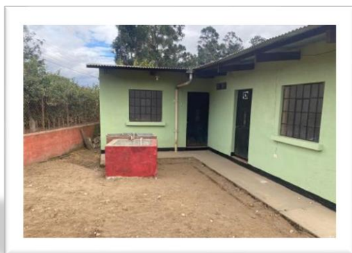
Fotografía No. 1 – Estado actual. Elaboración propia.
