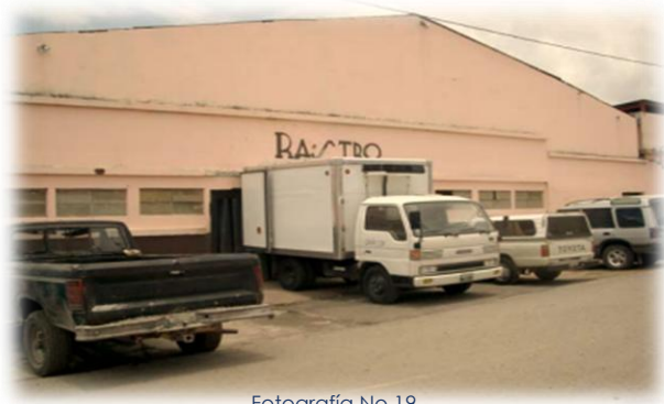
Fotografía No.19 Rastro Municipal de Santa Catarina
