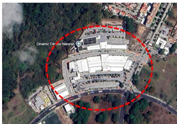
Figura 70. Construcción Pasaje Naranjo Fuente: google earth
