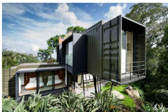
Figura 4. Exterior Casa Ecco
