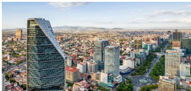
Figura 16. Vista Edificio Torre Reforma Fuente: página Torre Reforma, www.group.schindler.com/
