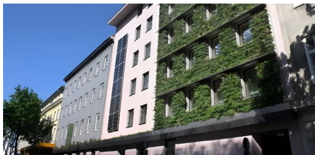
Figura 18. Exterior Hotel Stadthalle Fuente: hotel Stadthalle, https://inarquia.es/
