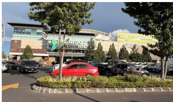
Figura 27. Área parqueos Naranjo Mall Fuente: propia, fachada principal, hacia el sur.
