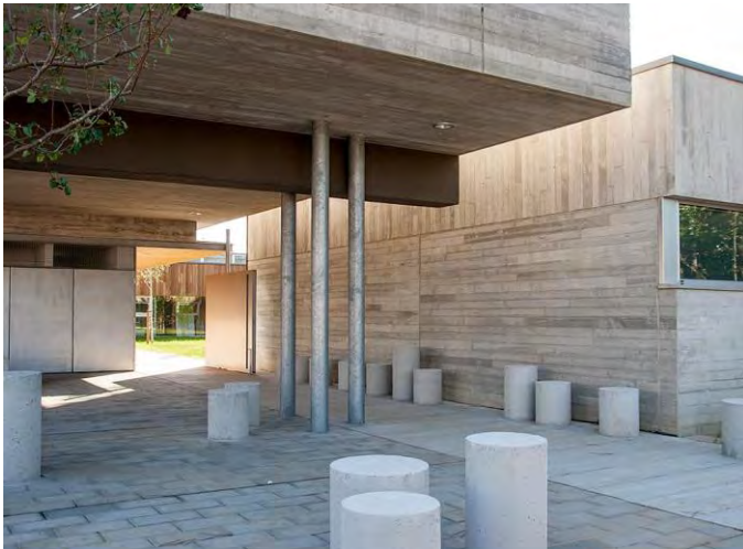
IMAGEN 22. Ingreso principal Centro de Salud de Oroso en España. Fuente: VEREDES, arquitectura y divulgación. https://veredes.es . Autor: BIS Images.
