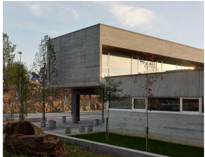
IMAGEN 23. Ingreso principal Centro de Salud de Oroso en España. Fuente: VEREDES, arquitectura y divulgación. https://veredes.es . Autor: BIS Images.
