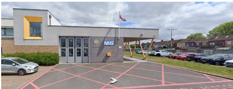
IMAGEN 9. Acceso área de emergencia Centro de Atención Integrada, Jean Bishop. Fuente: Google Maps, street view.
