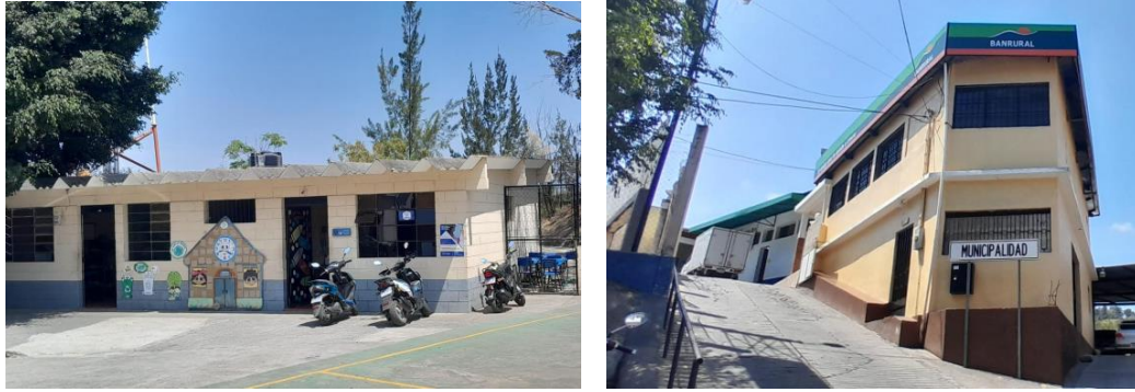
Figura 30. Edificaciones de San Antonio La Paz. Fuente: elaboración propia, 2025.
