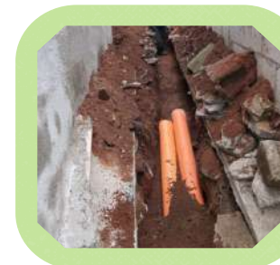
Foto 43 - Instalación de drenajes Fuente: MuniSALP, 2025
