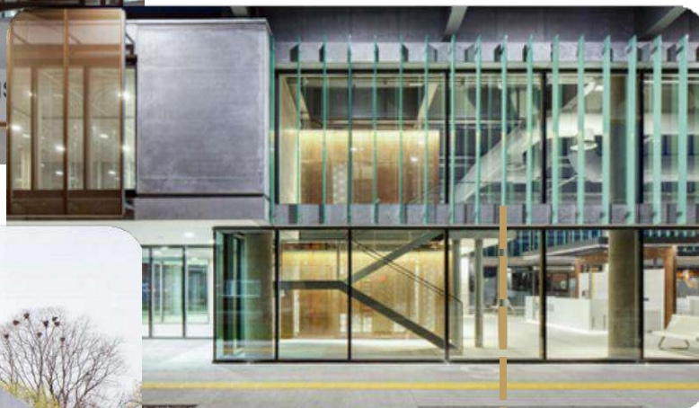
Figura 27: Fachada del proyecto.
