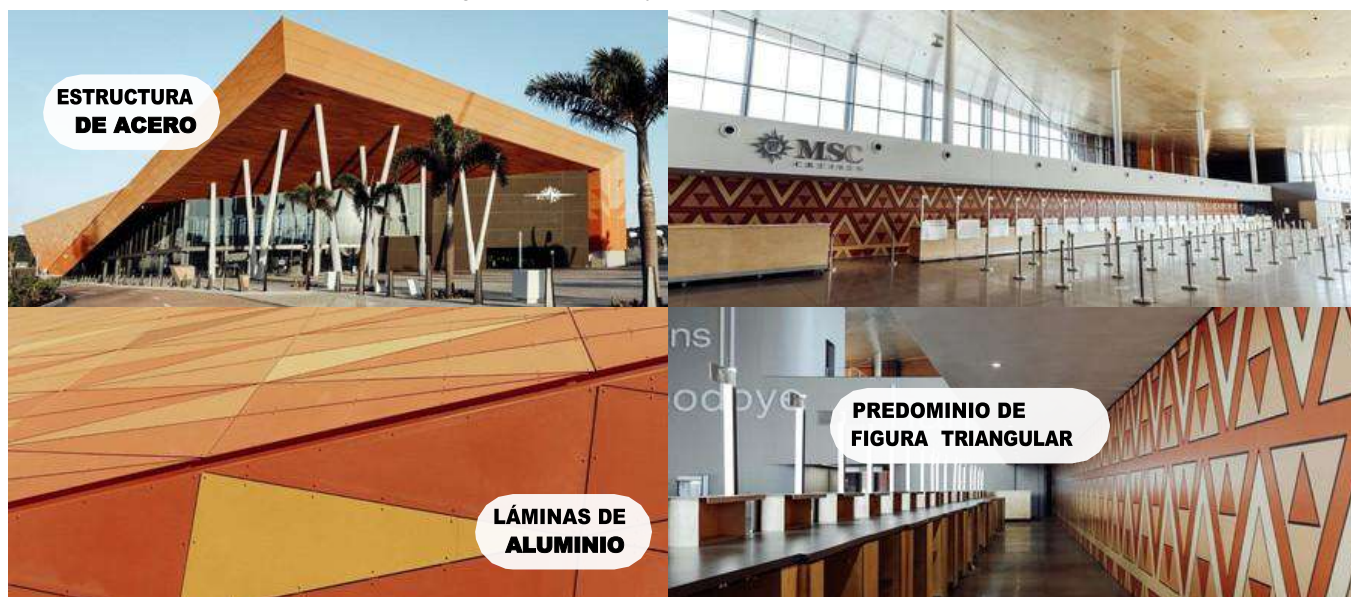
Figura 10, 11, 12 y 13: Elementos constructivos.
