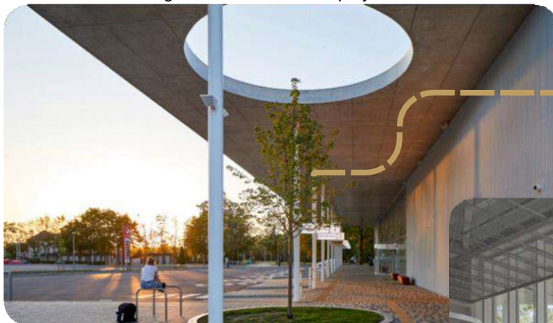
Figura 19: Vista aérea proyecto.
