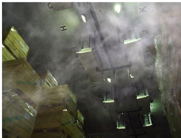
Figura 15. Área de trabajo inundada de vapor
