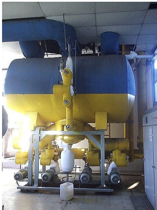
Figura 16. Sistema de condensación seco, es pequeño y caro
