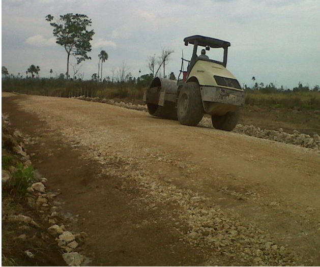
Figura. 13 Compactación de balasto
