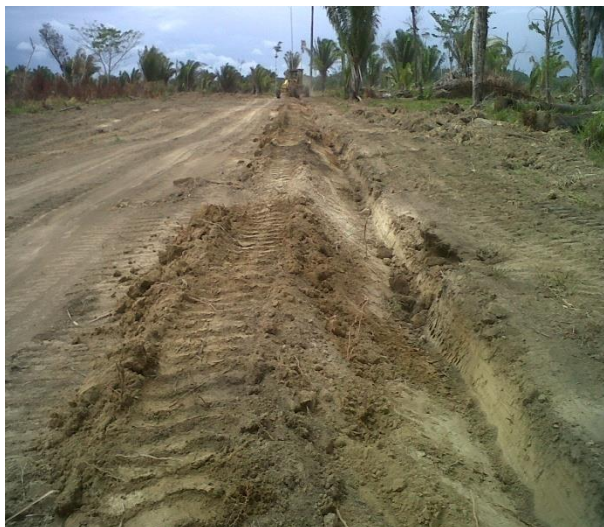
Figura. 12 conformación y talud de cuneta en vía primaria.,
