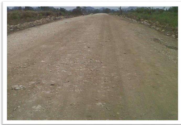
Figura. 13 Compactación de balasto
