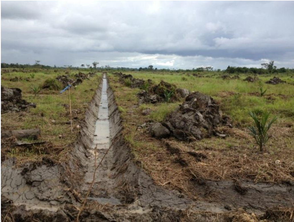
Figura 19. Canal de drenaje terciario con balde trapezoidal.
