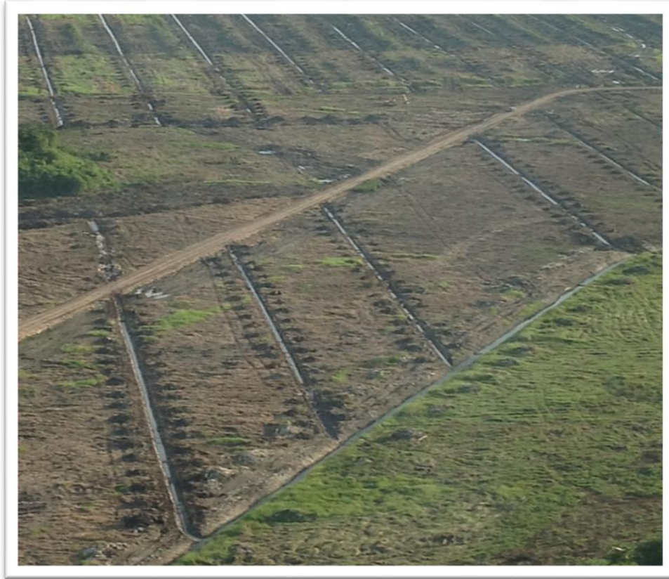
Figura 17. Canales terciarios conectados al drenaje recolector
