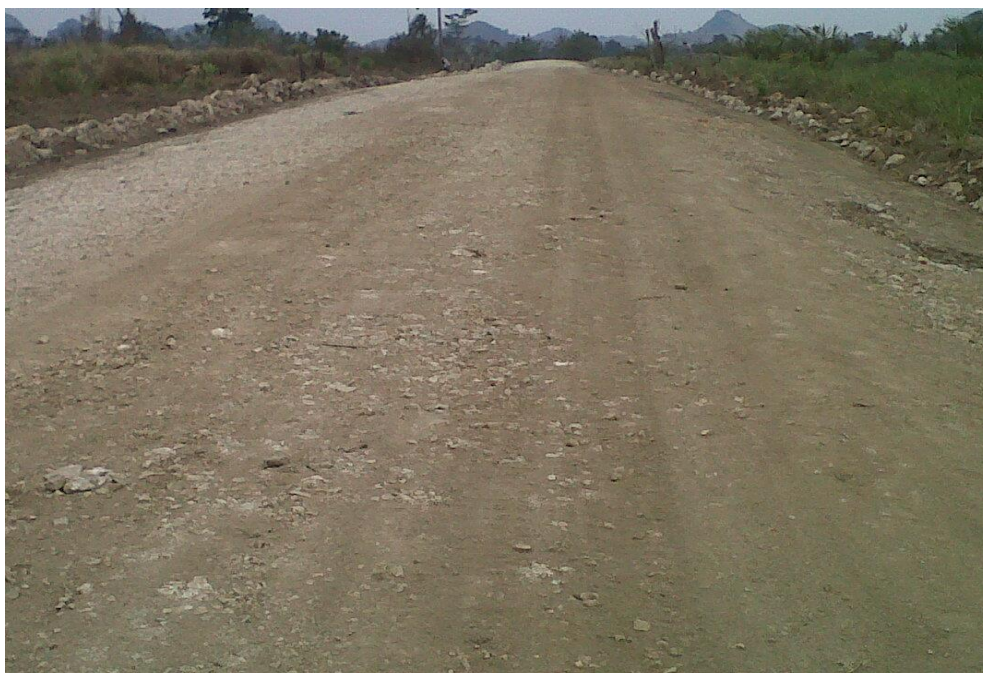
Figura 38. Vía primaria terminada.
