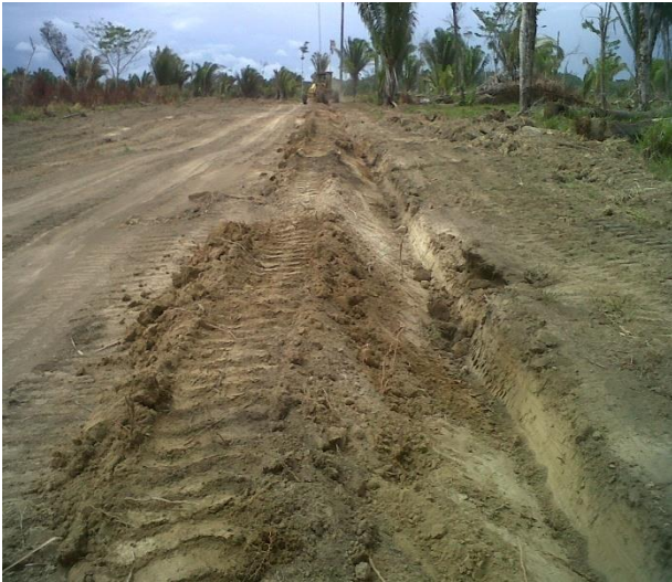
Figura. 36 Conformación y talud de cuneta Figura. 37 Compactación de balastro
