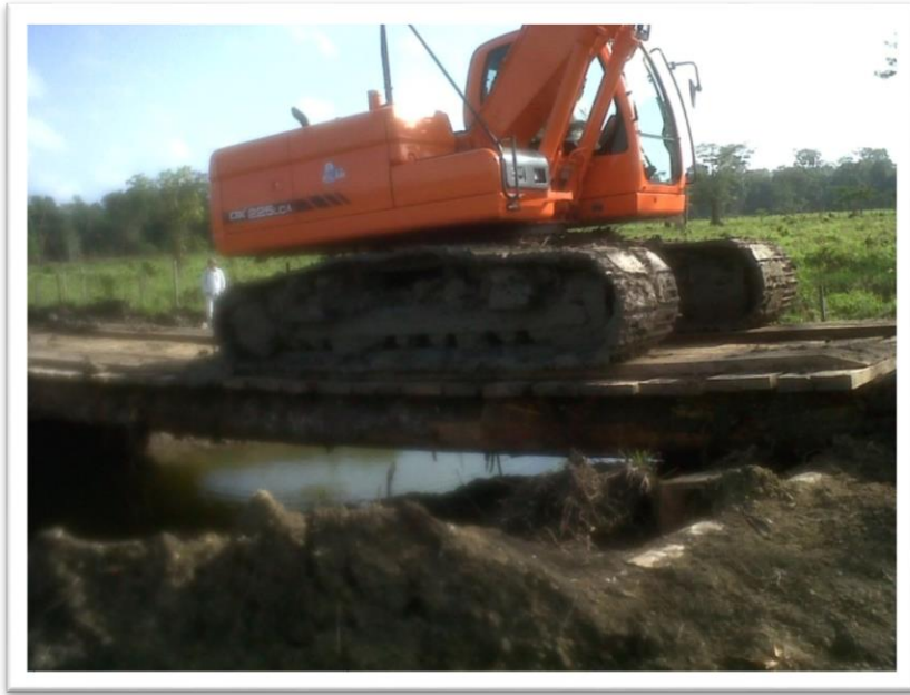
Figura. 15 Puente construido con madera dura.
