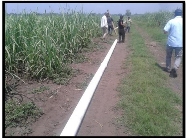
Figura 64. Instalación de la tubería pvc
