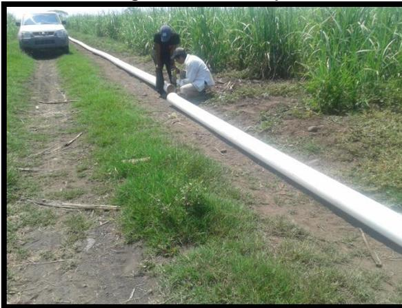
Figura 63. Instalación de la tubería de pvc
