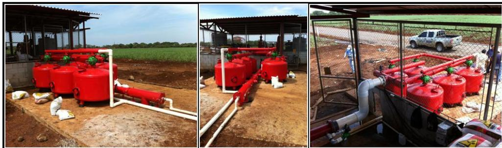
**Figura 81.** Equipo de filtrado de grava.
