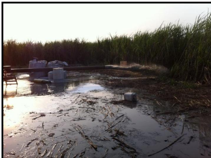
**Figura 28.** Limpieza de pozo con aire comprimido.
