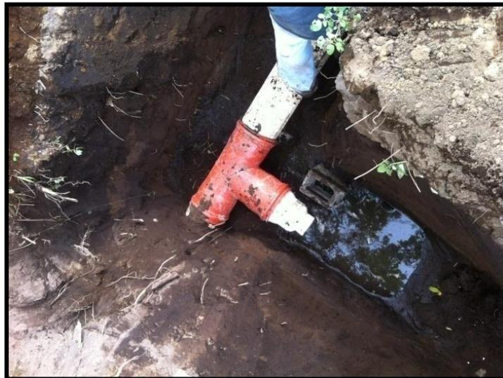
**Figura 61.** Instalación de accesorio epóxico.
