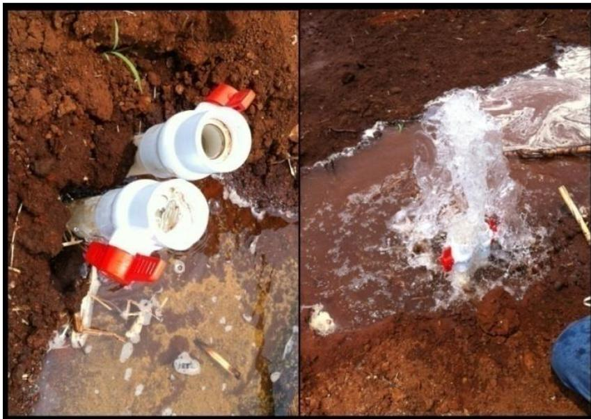
**Figura 54.** Llaves de bola para limpiar la tubería colectora.
