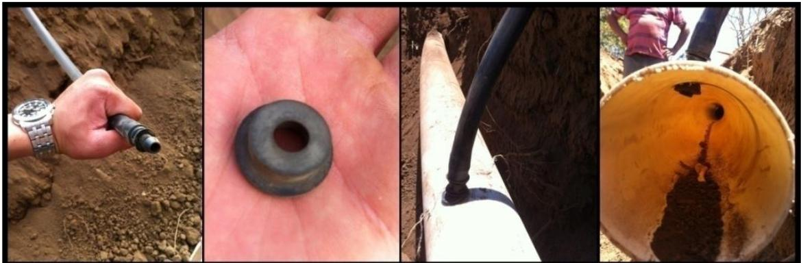
**Figura 53.** Instalación de los elevadores y sus empaques.
