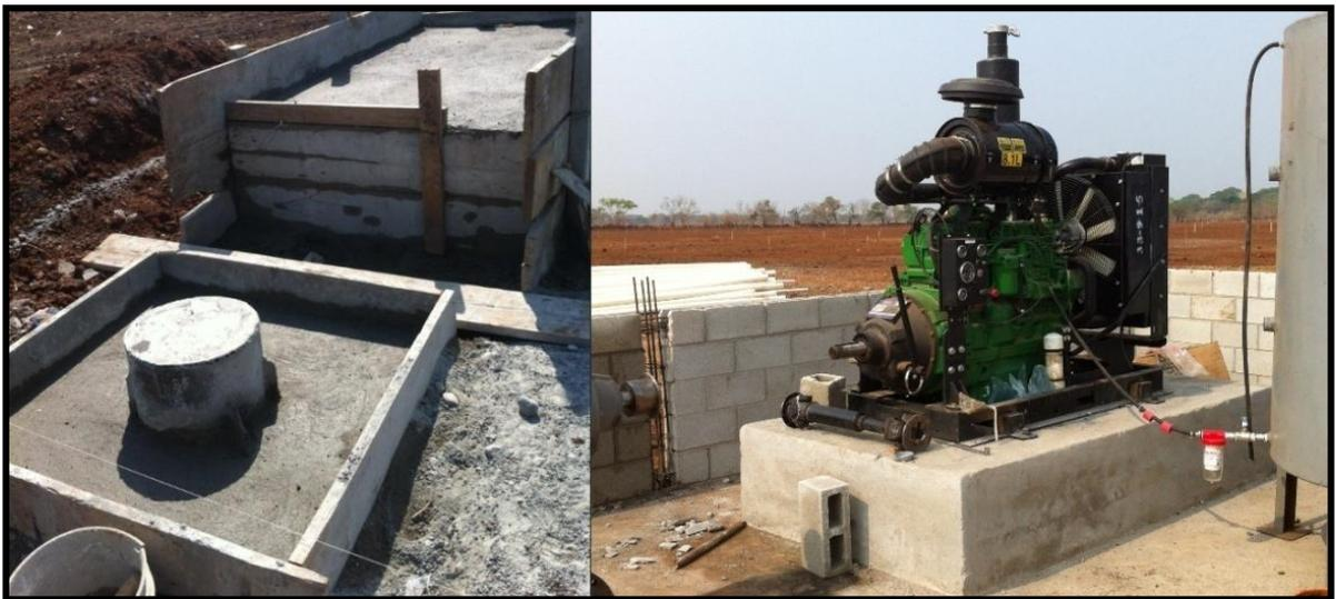
**Figura 30.** Base cementada para colocación de motor.
