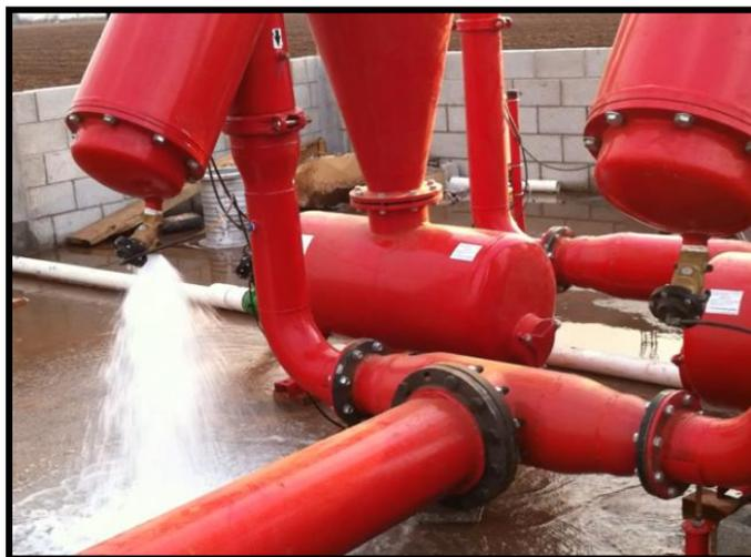
**Figura 41.** Apertura de la válvula hidráulica del retrolavado.
