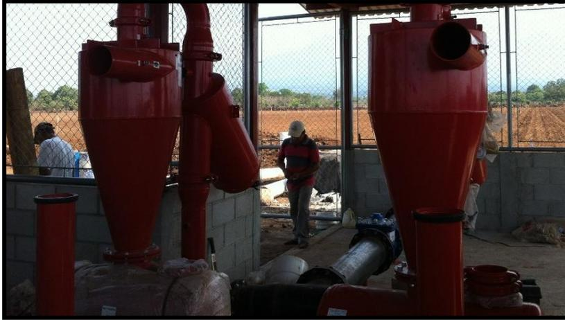
**Figura 34.** Hidrociclones del sistema de filtrado.
