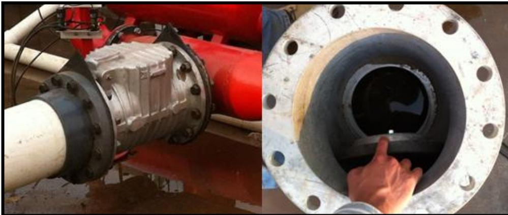
**Figura 32.** Válvula de cheque del sistema de bombeo.
