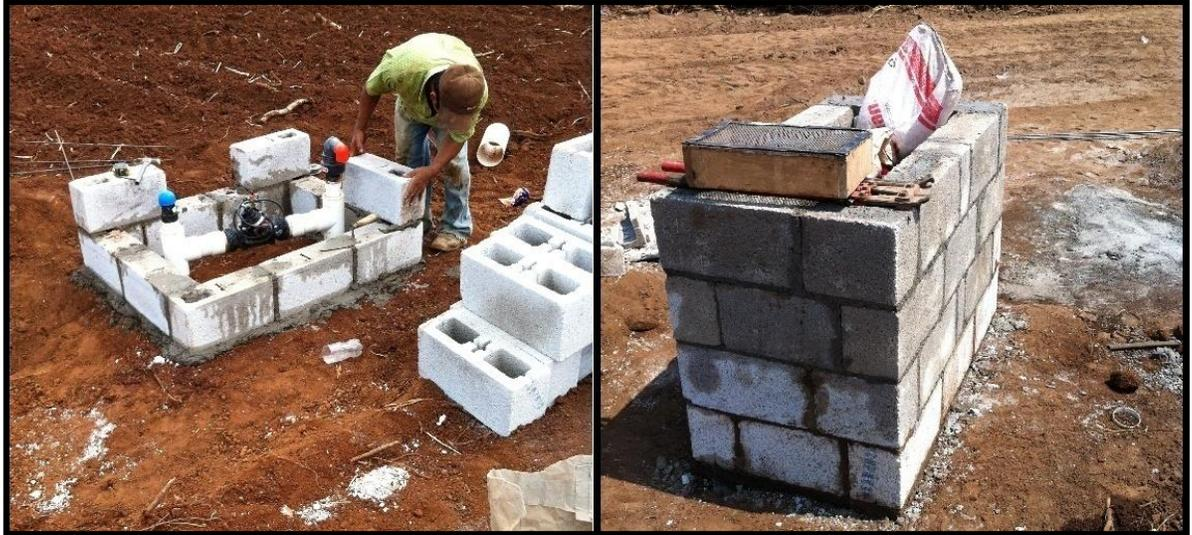
**Figura 58.** Construcción de cajas protectoras para válvulas hidráulicas.
