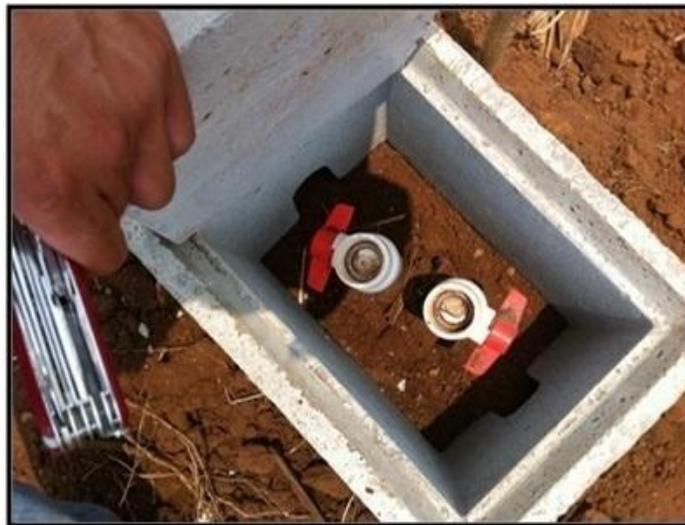
**Figura 59.** Caja prefabricada para protección de las válvulas de bola.
