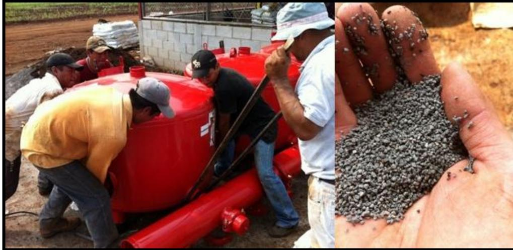
**Figura 38.** Instalación de los filtros de grava y el medio filtrante.
