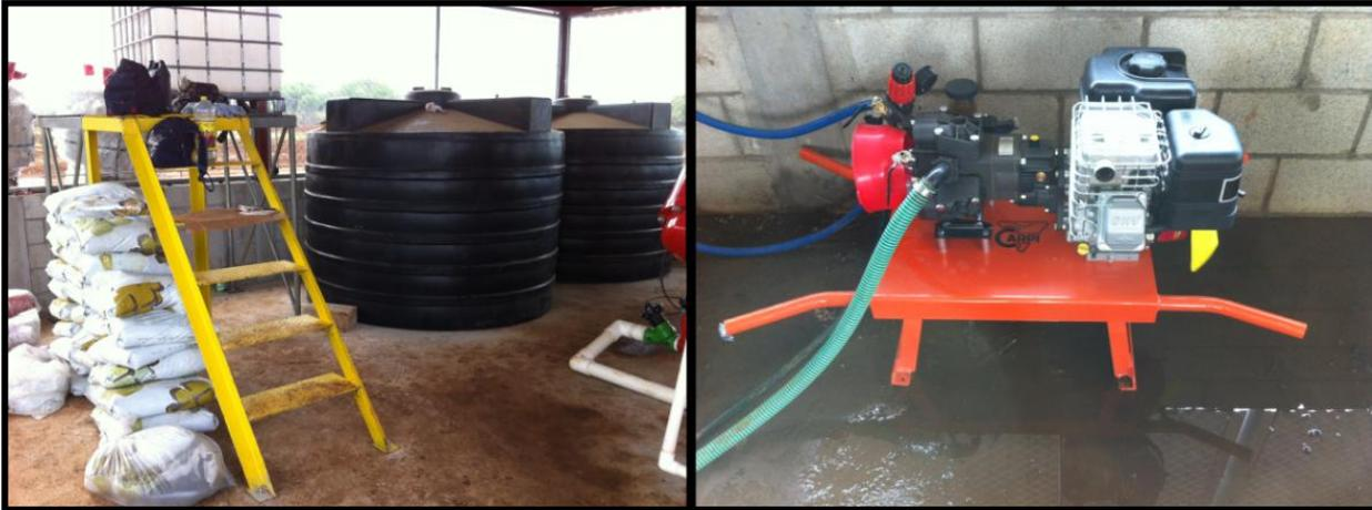
**Figura 42.** Depósitos y bomba del sistema de fertiriego.
