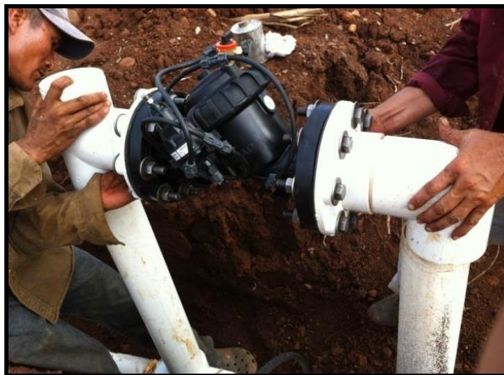
**Figura 56.** Instalación de caballete para válvula hidráulica de 3 pulgadas.
