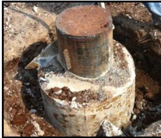
**Figura 23.** Antepozo relleno con concreto.
