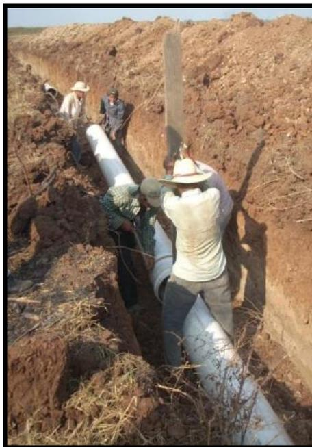
**Figura 46.** Instalación de tubería principal de junta rápida.
