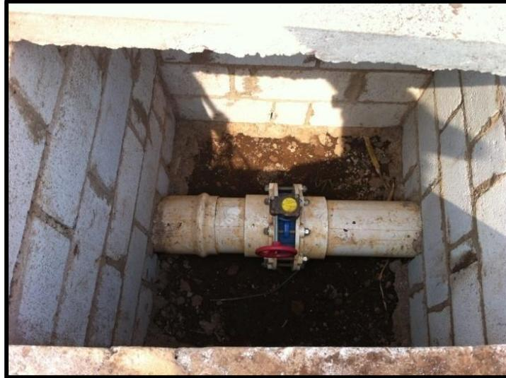
**Figura 55.** Instalación de válvula sectorial.
