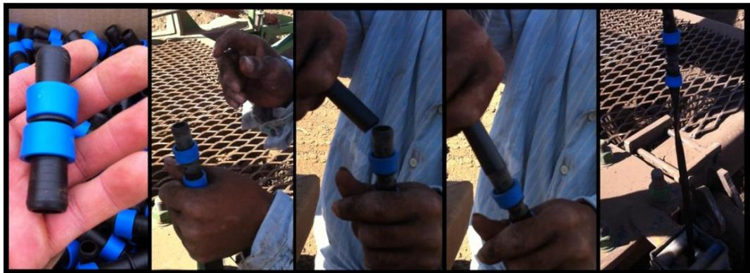
**Figura 49.** Instalación de acoples para las mangueras.
