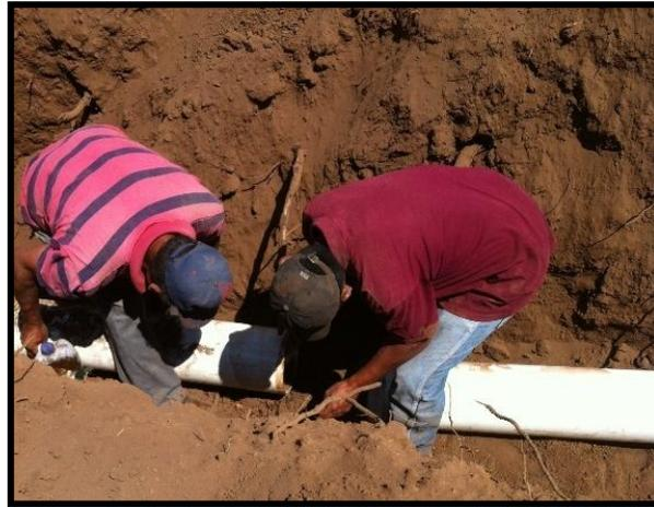
**Figura 52.** Instalación de línea secundaria.
