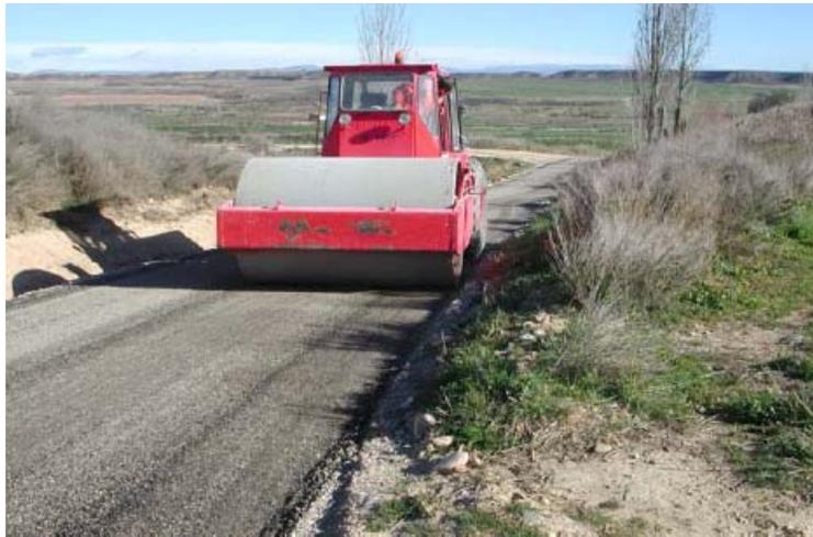
**Fig. 4.4.14 Compactando el material pero sin vibrar**
