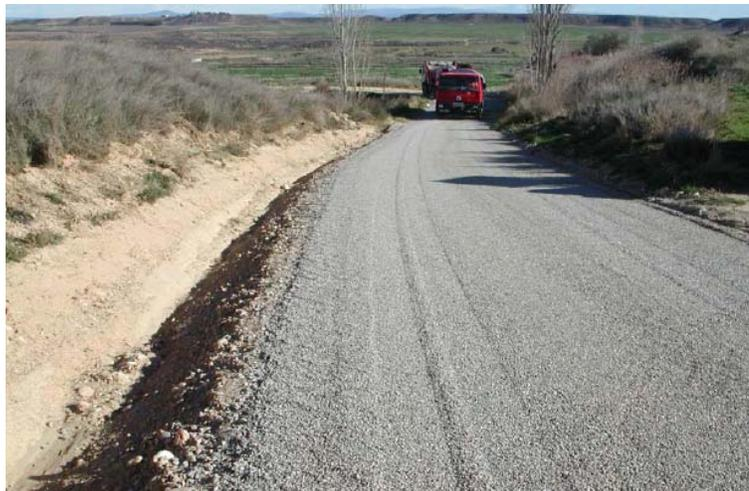
**Fig. 4.4.14 Acondicionamiento y explanación de los materiales**
