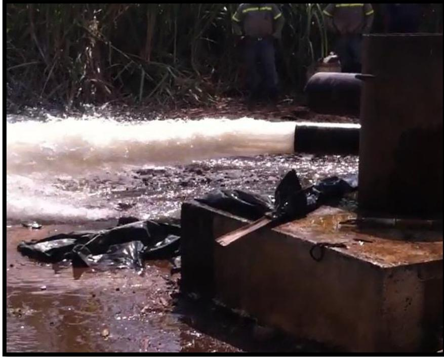
**Figura 32. Limpieza de la tubería principal de conducción.**
