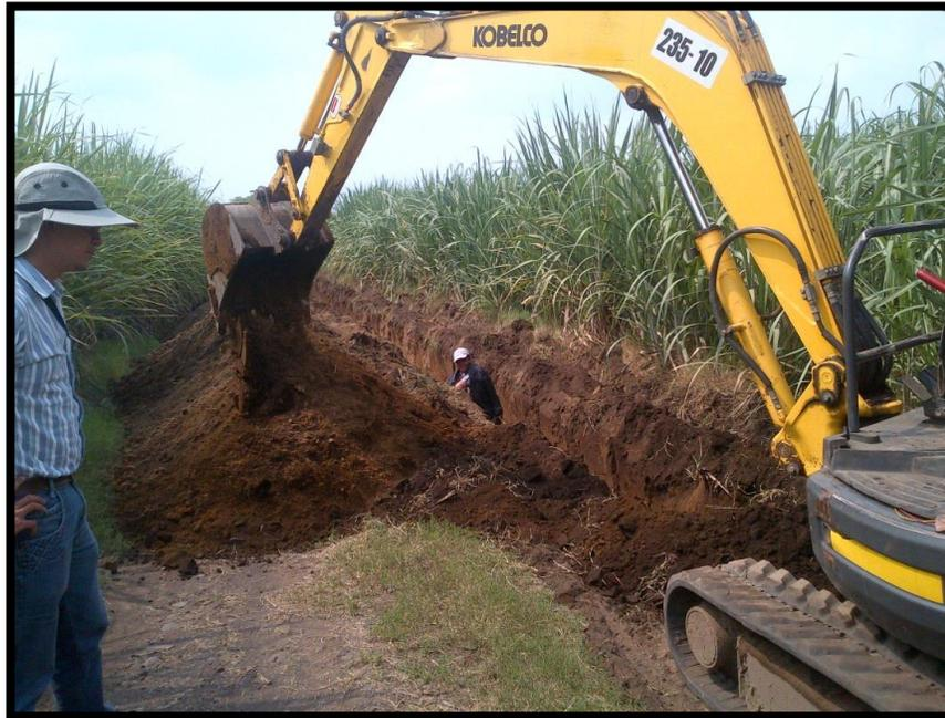
**Figura 24. Excavación de la tubería principal de conducción.**
