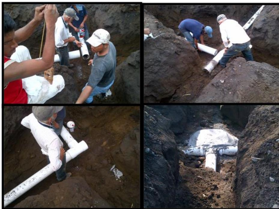
**Figura 26. Proceso de instalación de la Tee de conducción principal.**
