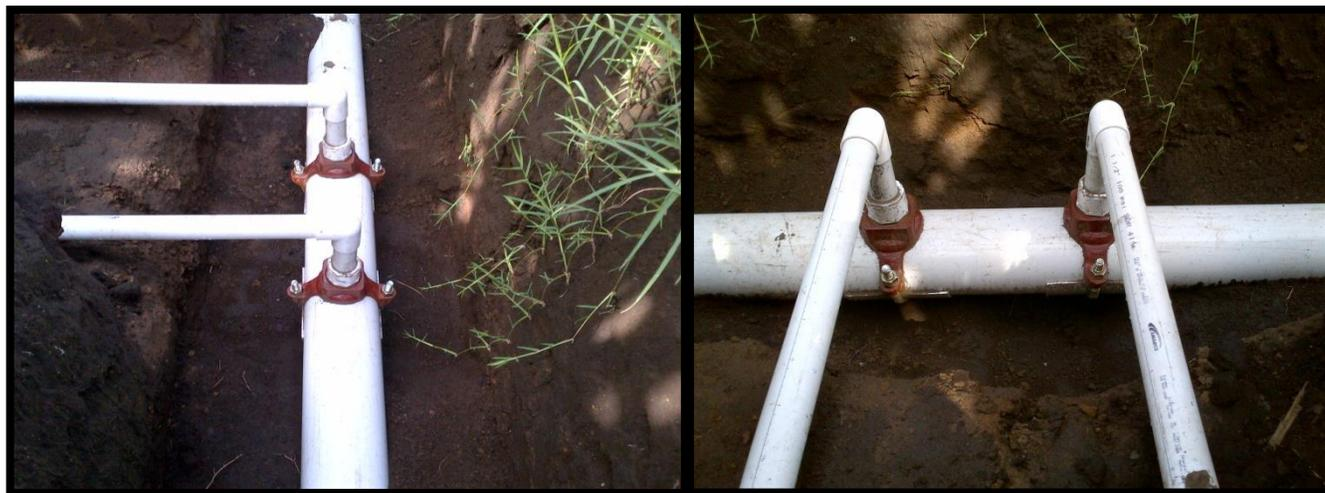
**Figura 31. Conexiones de la tubería secundaria a la principal.**
