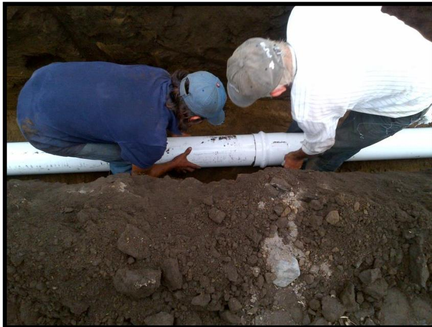
**Figura 25. Acople de tubos para la conducción principal.**
