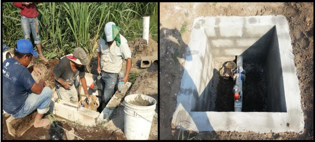
**Figura 34. Construcción de las cajas sectorizadoras con las llaves de paso.**
