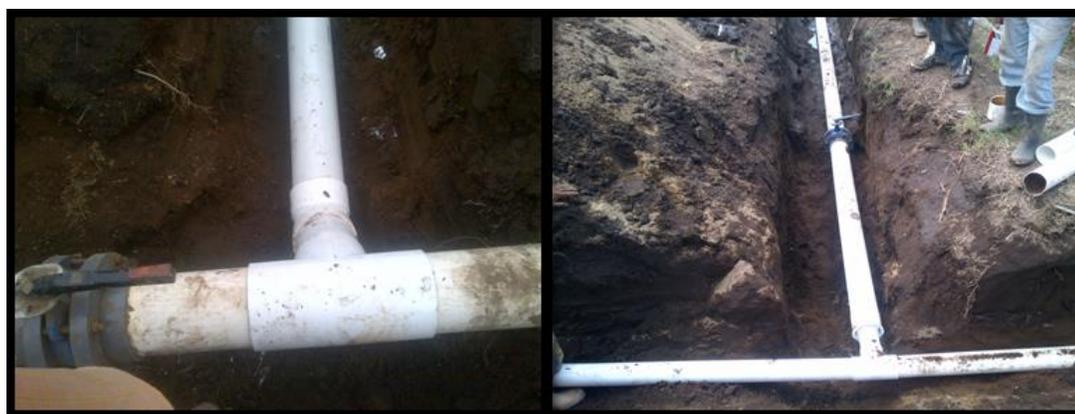
**Figura 27. Acoples de la tubería principal a las fuentes de agua.**
