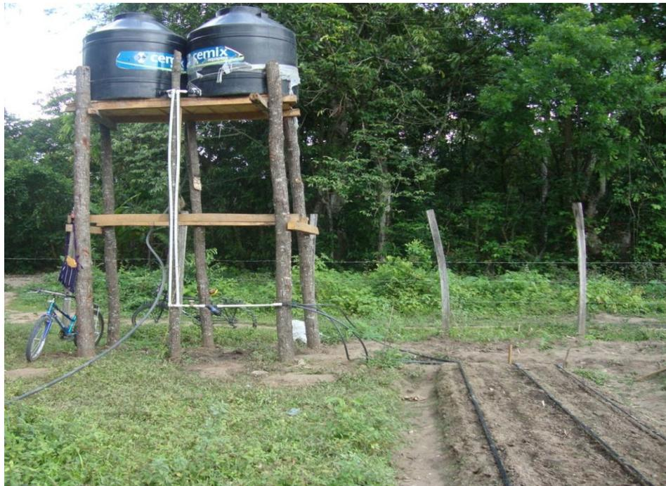
**Figura 19** Sistema de riego instalado en la Aldea Rincón de Jesús.
