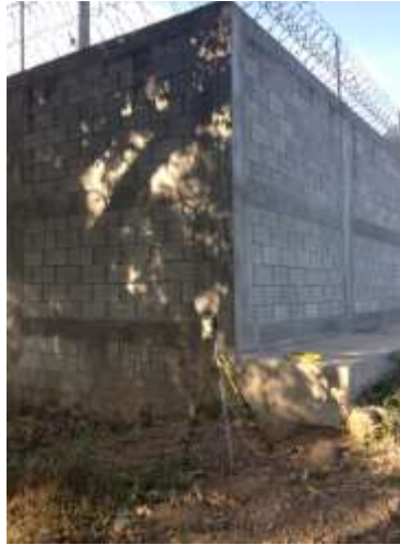
Figura 13. Medición campo magnético colindancia 1 subestación El Milagro
