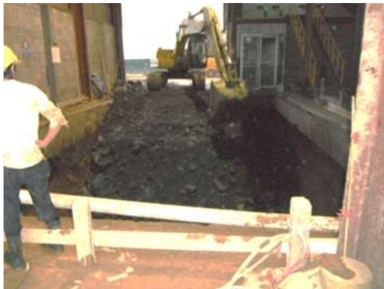
Figura 4. Aplicación de la capa de rocas y arena volcánica
