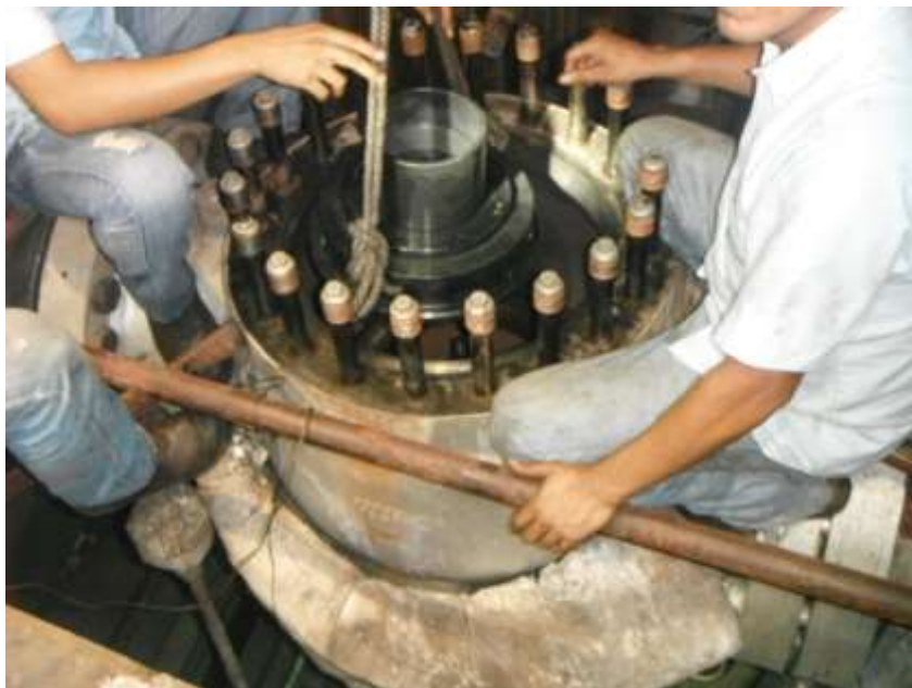
Figura 30. Instalación de la válvula de emergencia stop valve
