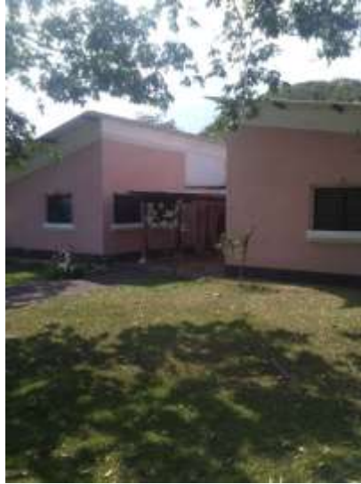
Figura 4. Entrada a oficinas centrales
