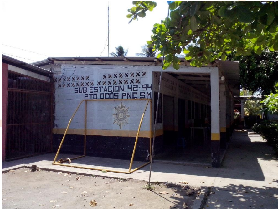
Fotografía15Sub Estación PNC. Fuente: Víctor Palacios. 2013
