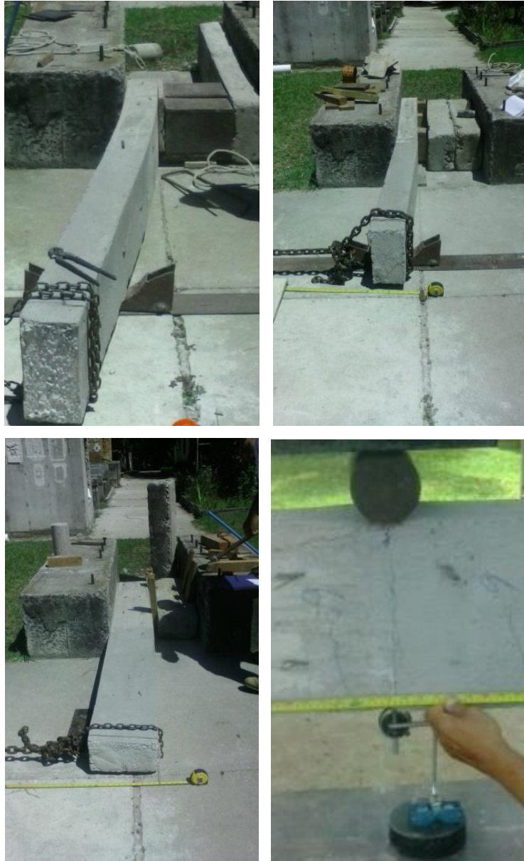
Figura 14. Deformación de columnas
