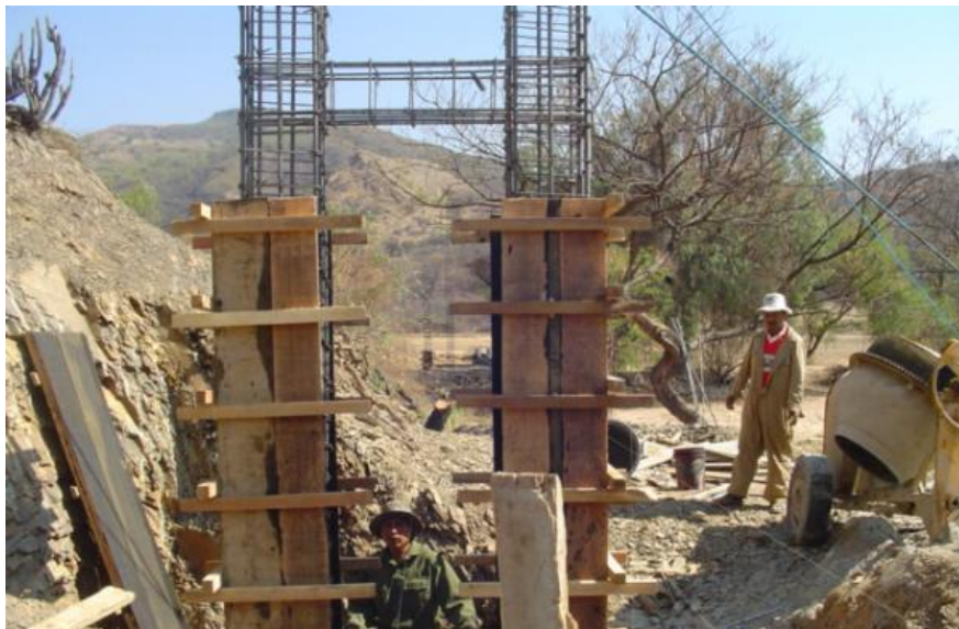
Figura 6. Encofrado de columnas con madera
