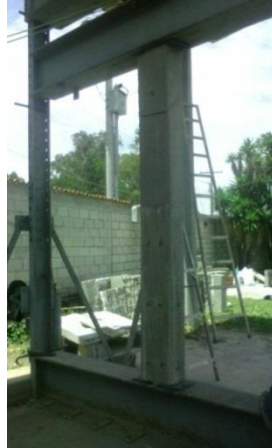
Figura 10. Ensayo de columna a compresión
