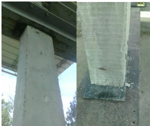
Figura 11. Aparición de grietas en ensayo a compresión
