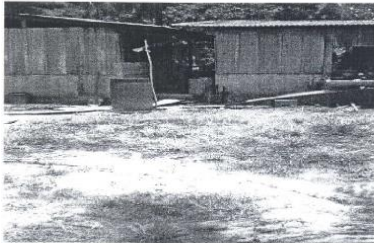
Comunidad Mojanales: licuefacción y asentamientos diferenciales
