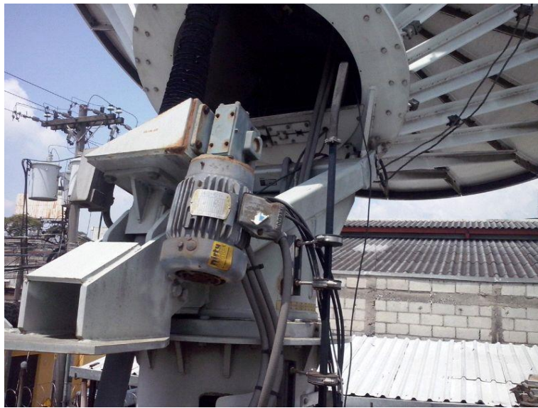
Figura 19. Motor para movimiento de elevación
