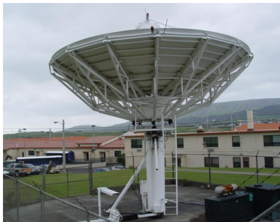
Figura 8. Antena parabólica Cassegrain
