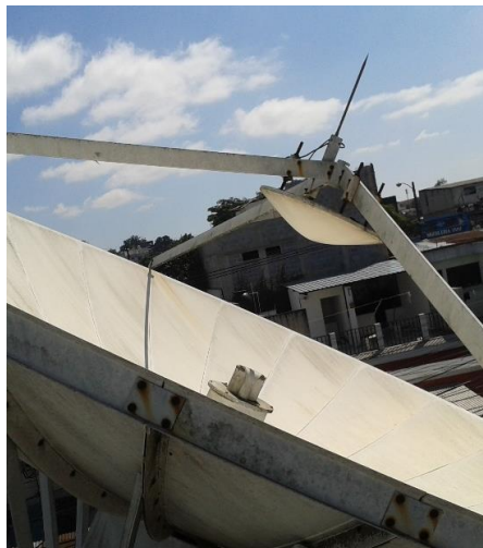
Figura 16. Punta de Faraday en el subreflector
