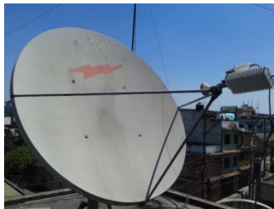
Figura 7. Antena parabólica offset
