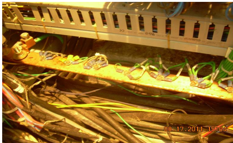
Figura 65. Barra equipotencial saturada de terminales
