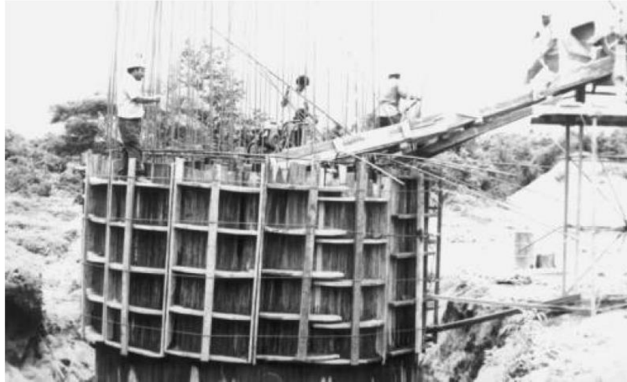
Figura 29. Colocación de molde de un caisson
