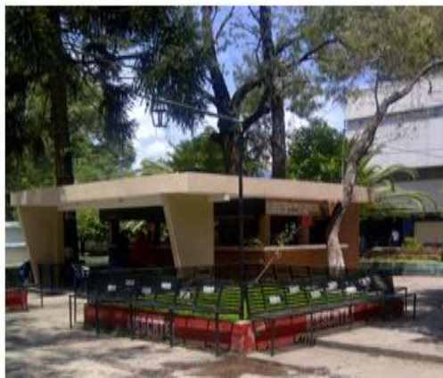
Figura 48. Cafetería con cilindro de gas propano
