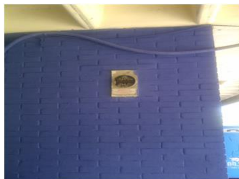
Figura 50. Cables eléctricos expuestos
