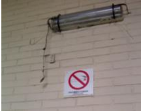
Figura 40. Lámparas de emergencia desconectadas
