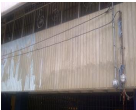
Figura 50. Cables eléctricos expuestos
