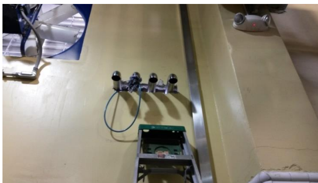
Figura 25. Pasivado de tuberías
