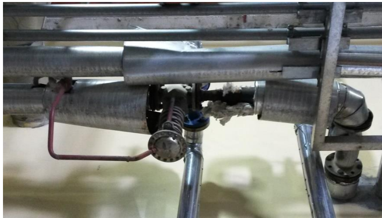
Figura 12. Amortiguador de golpe de ariete
