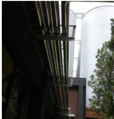
Figura 27. Tuberías aisladas
