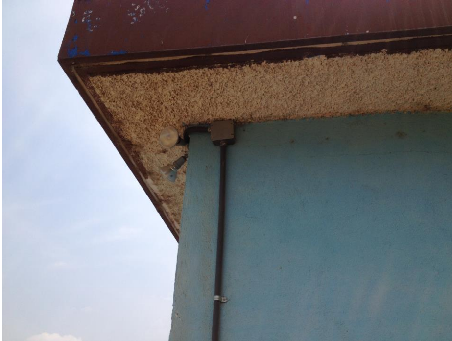
Figura 10. Tubo PVC eléctrico y reflector
