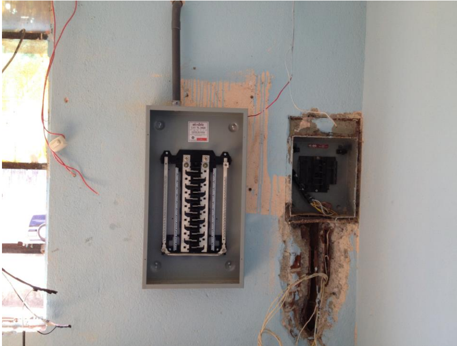
Figura 8. Puesta del tablero principal
