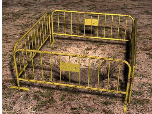
Figura 11. Protección para la caída de terreno suelto
