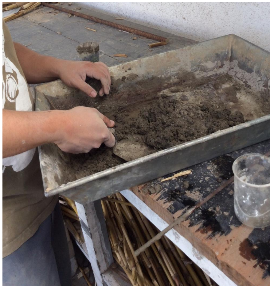
Figura 3. Mortero utilizado para la fundición de los pines y llaves del prisma
