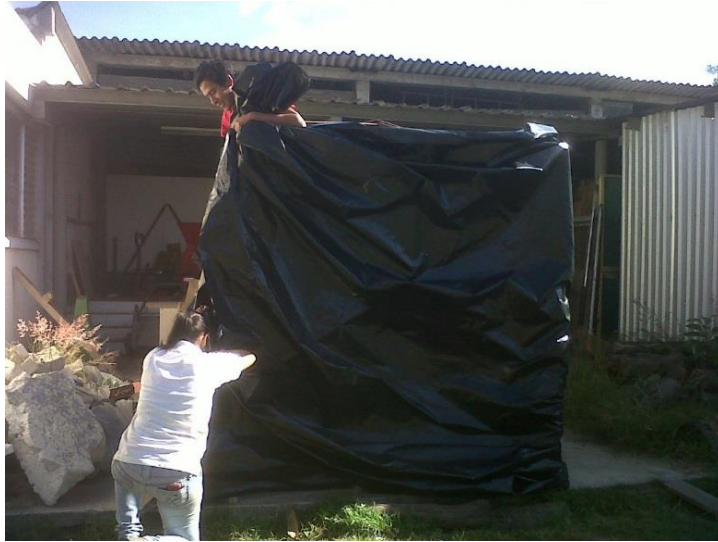
Figura 27. Forro de la cámara de curado tipo invernadero
