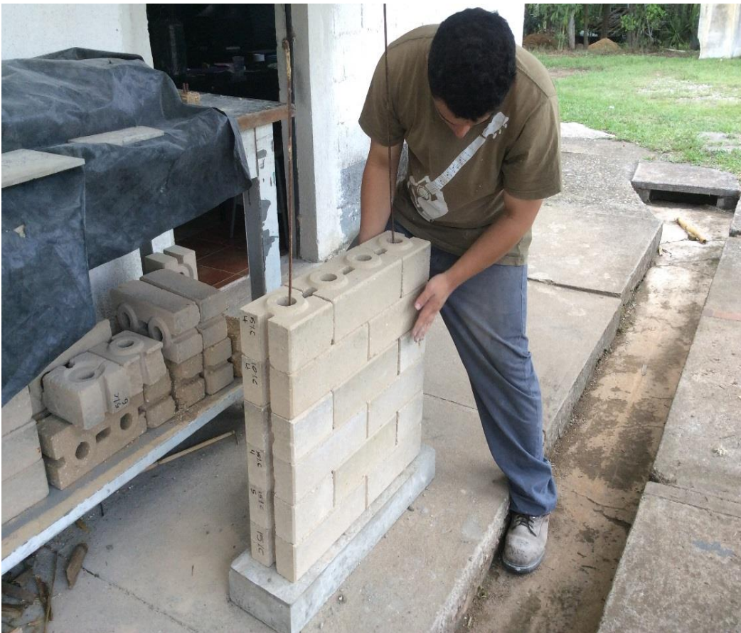
Figura 4. Colocacion de hilera de BTC en el levantado del prisma
