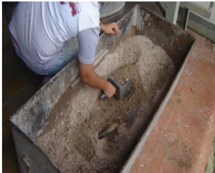
Figura 43. Mezclado del material para la fabricación de los BTC
