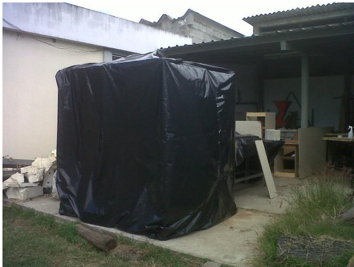
Figura 28. Cámara de curado tipo invernadero
