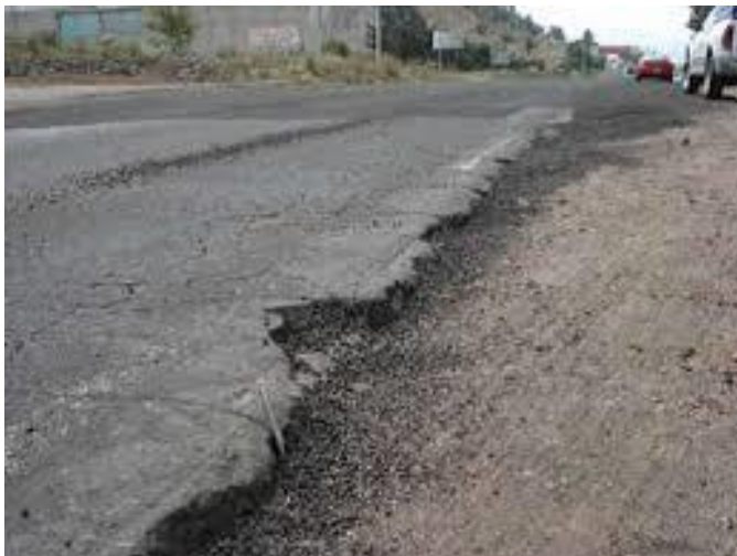
Figura 20. Desintegración de bordes
