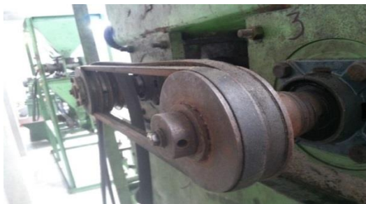
Figura 17. Vista de correas de transmisión para molienda en área de premolido
