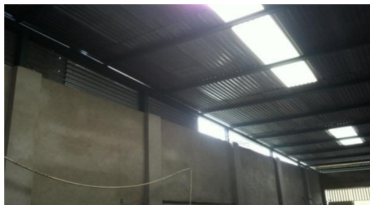
Figura 35. Vista de entrada de aire en área de Producción
