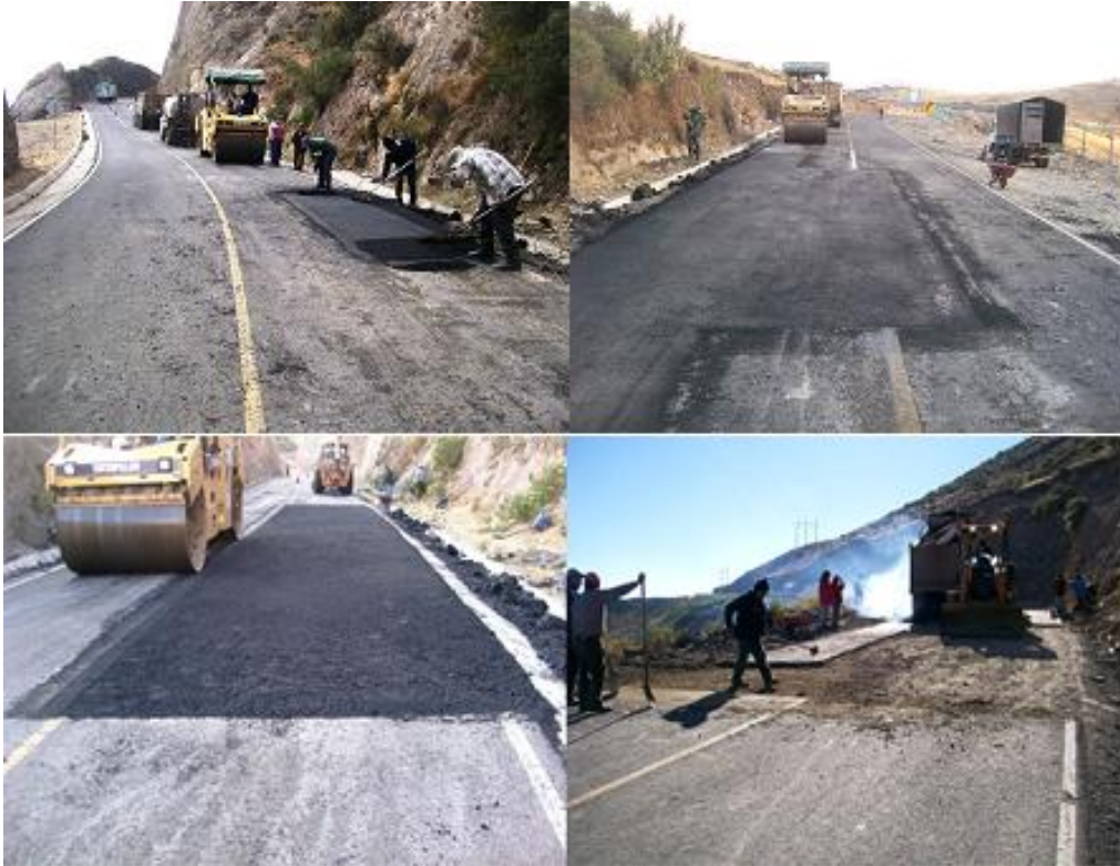
Figura 13. Reparaciones en el tramo tipo “B”
