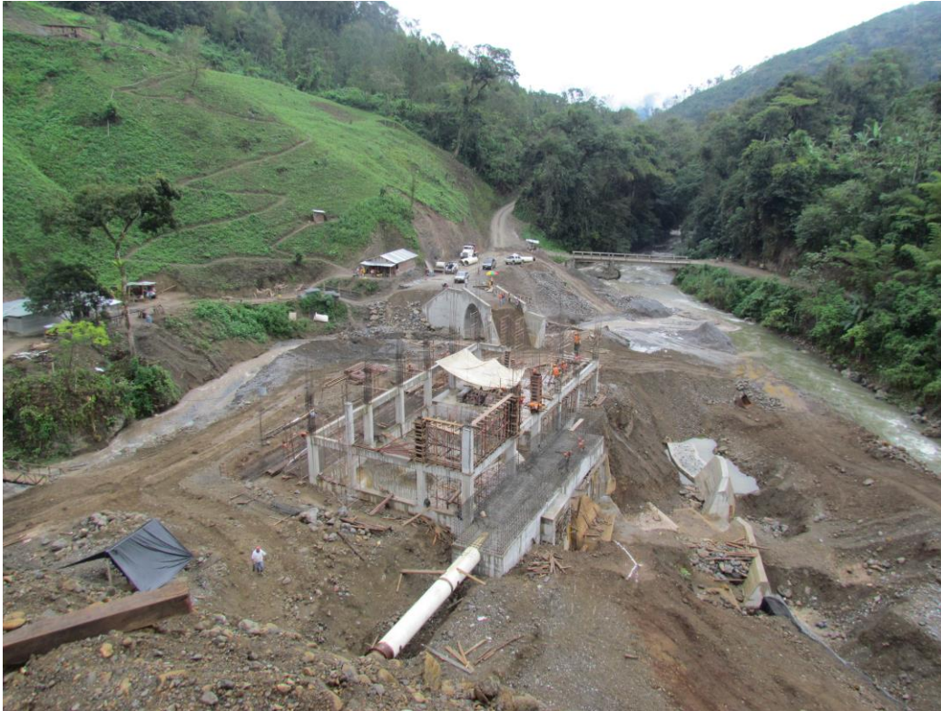
Figura 16. Proyecto hidroeléctrico en construcción de El Cafetal
